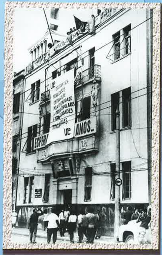
Estudantes resistem à demolição do prédio incendiado da sede da UNE, em 1979
